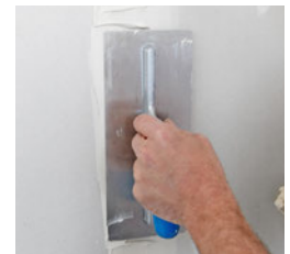
Ausdrücken und blasenfreies Verfüllen
