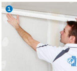
Abschlusskante ausrichten
