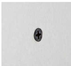
Korrekt eingedrehte Schraube
