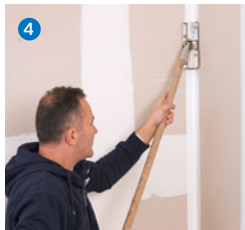
Innenkante mit dem Rigips Innenkantenroller
