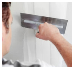
Spachteln ohne Rigips-Bewehrungsstreifen
